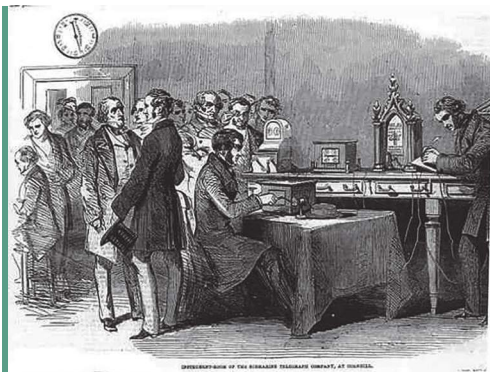
Невідомий художник. Отримання першого повідомлення Submarine Telegraph Company в Лондоні з Парижа за допомогою приладу Foy-Breguet у 1851 р. Обладнання на задньому плані — установка Кука — Уїтстона для подальшого передавання інформації. 1852 р.
