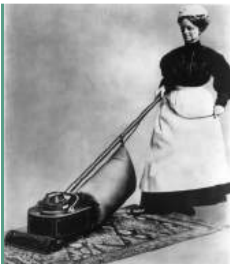
Перша модель пилосмока, запатентована в 1908 р. Джеймсом Мюрреєм Спенглером та випущена на ринок компанією «Electric Suction Sweeper Company»
