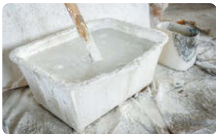
Мал. 34.5. Гасіння негашеного вапна водою супроводжується виділенням значної кількості теплоти
