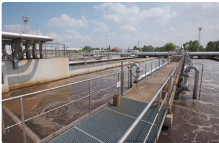
Мал. 8.1. Водоочисна станція, на якій річкову воду готують для подання в мережу водогону
