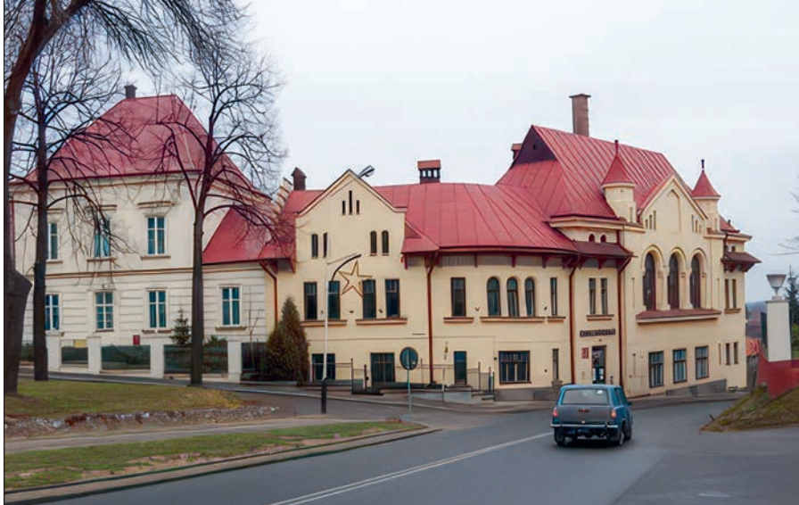
Будівля Українського народного дому «Просвіта» в місті Лежайськ (Польща). Сучасний вигляд
